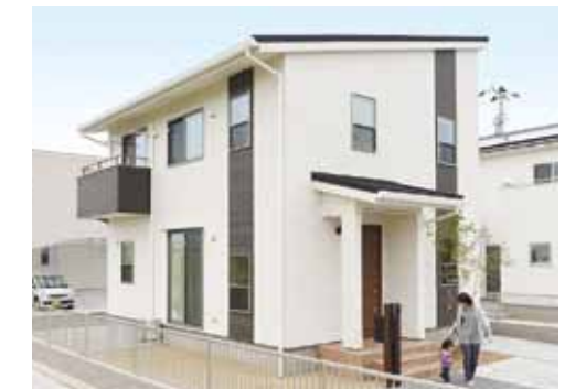
外壁はシーリングレスの特殊なサイディングを採用。継ぎ目がないので美しく、経年劣化が少ないのでキレイが長持ち。
